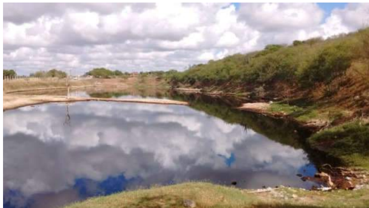
Figura 105 – Lagoa de chorume sem impermeabilização
