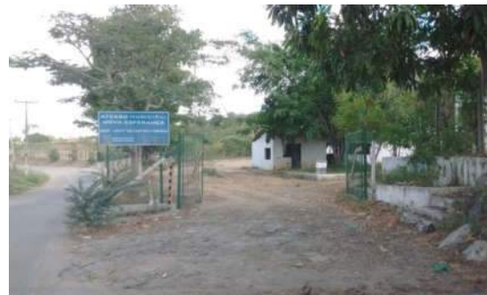
Figura 104 – Portão de entrada
