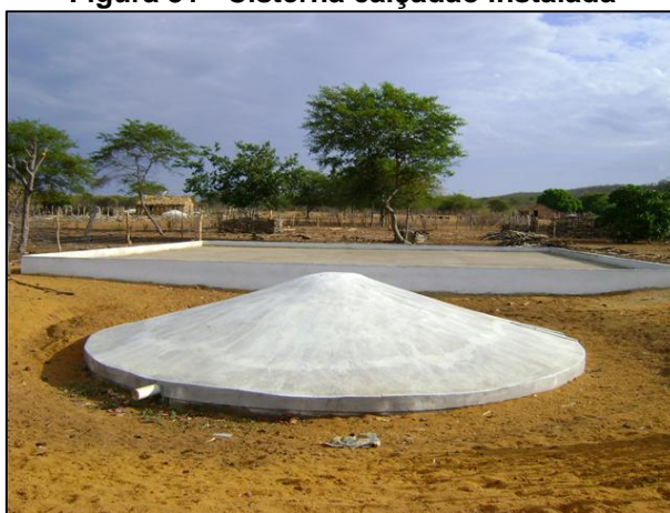
Figura 31 - Cisterna calçadão instalada
