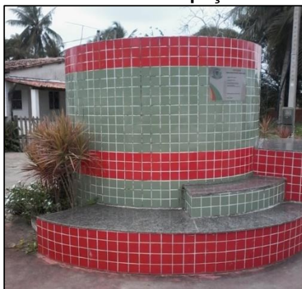
Figura 36 Estrutura externa de poço tubular escavado
