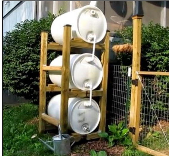
Figura 30 Cisterna de bica em sistema compacto
