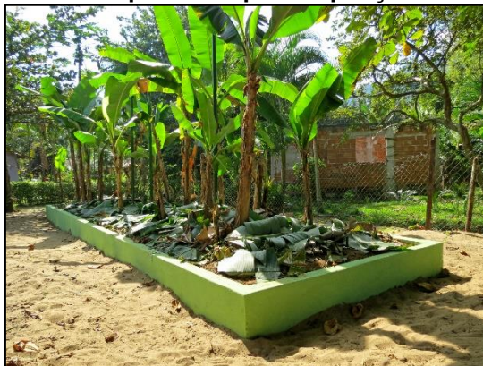
Figura 58 - Tanque de evapotranspiração construído
