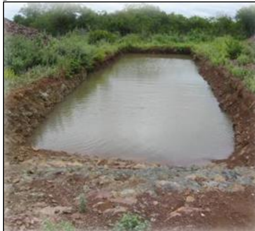
Figura 34 - Barreiro de trincheira construído
