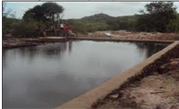
Figura 33 - Tanque de pedra ativo
