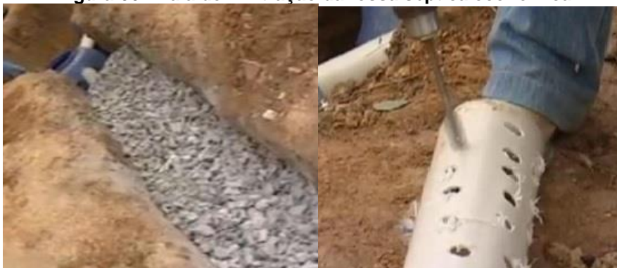
Figura 66 - Vala de infiltração da fossa séptica econômica
