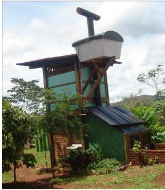
Figura 56 - Banheiro seco do IPEC
