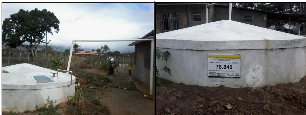
Figura 25 - Sistema de captação de água da chuva - Lagoa Suja
