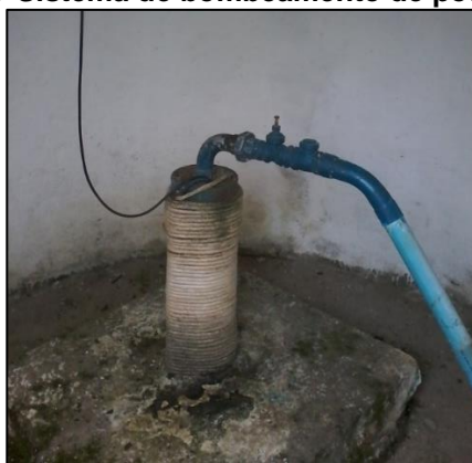
Figura 37 Sistema de bombeamento de poço tubular
