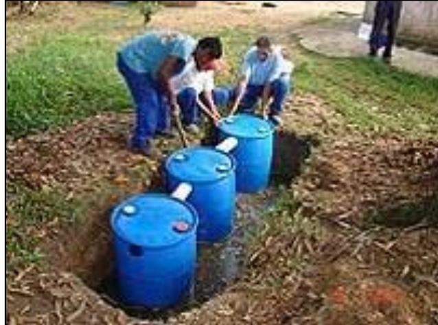
Figura 65 - Instalação da fossa séptica econômica
