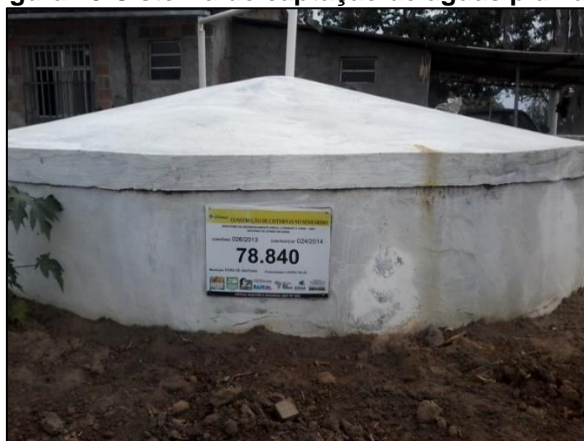
Figura 29 Cisterna de captação de águas pluviais
