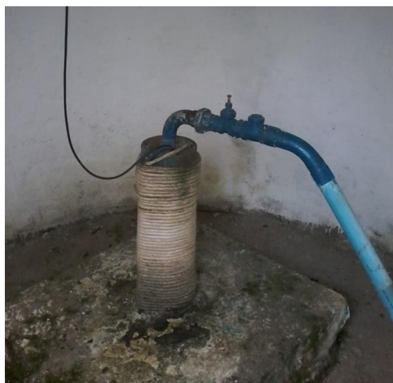
Figura 74 Sistema de bombeamento de poço tubular
