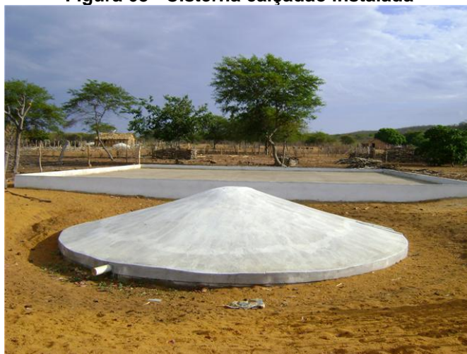
Figura 68 - Cisterna calçadão instalada
