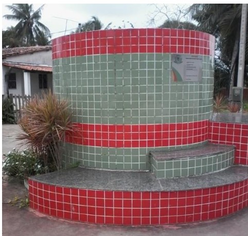
Figura 73 Estrutura externa de poço tubular escavado
