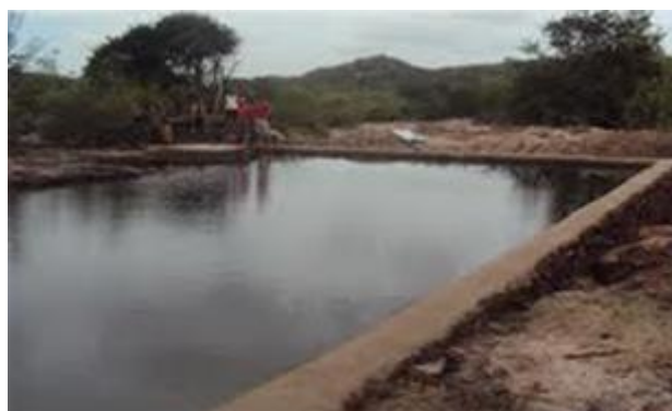
Figura 70 - Tanque de pedra ativo
