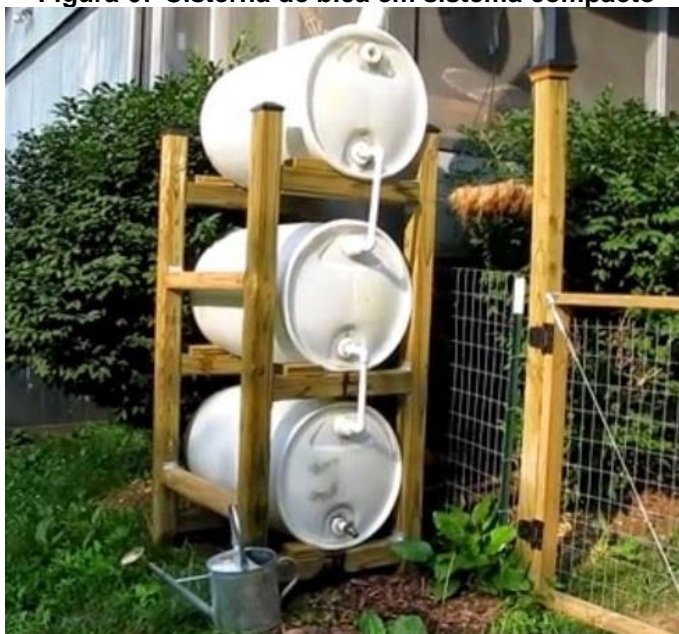
Figura 67 Cisterna de bica em sistema compacto
