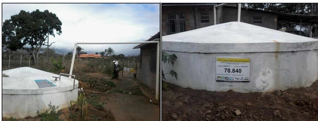
Figura 65 - Sistema de captação de água da chuva - Lagoa Suja
