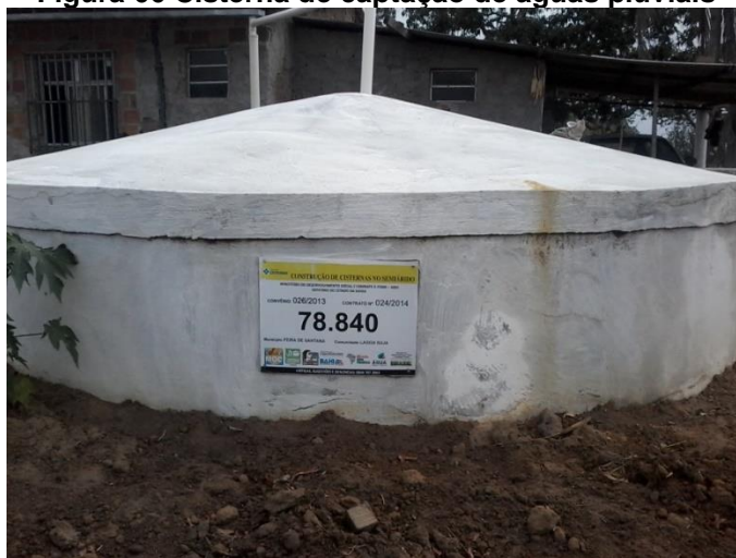
Figura 66 Cisterna de captação de águas pluviais
