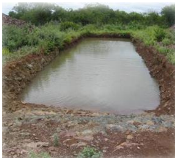
Figura 71 - Barreiro de trincheira construído
