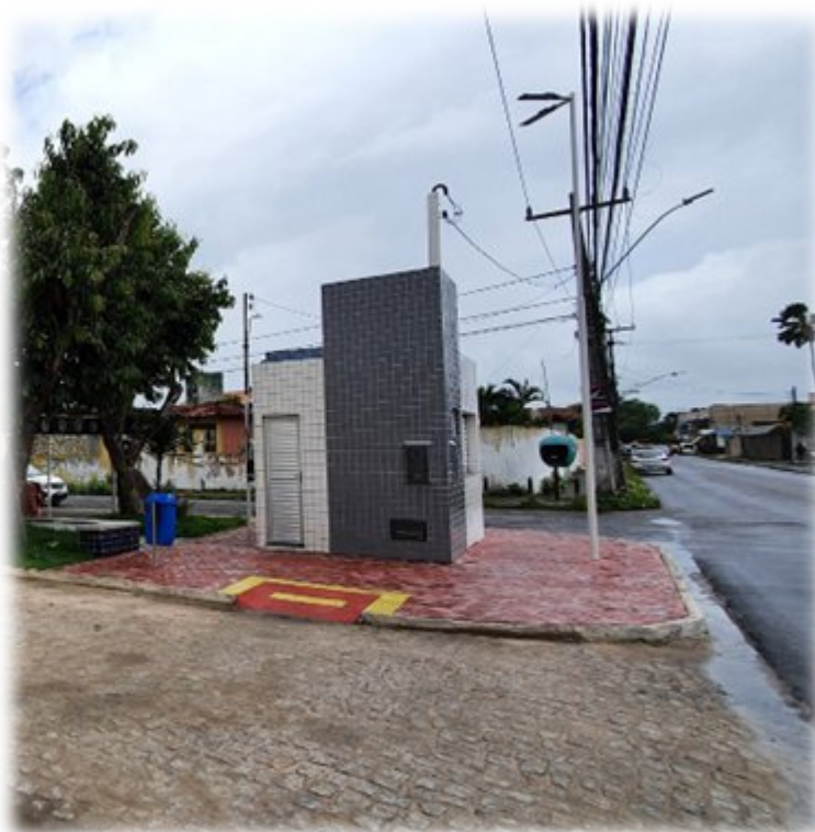
01 – IMAGEM LATERAL DO QUIOSQUE, VOLTADA PARA A RUA SEM DENOMINAÇÃO.
